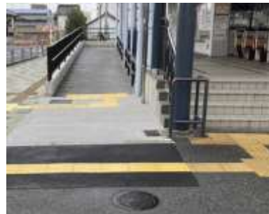
近鉄西田原本駅(田原本町)におけるスロープ改良 <2020(令和2)年度実施>
