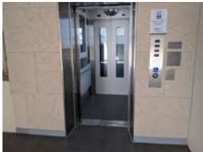
近鉄坊城駅(橿原市)におけるエレベーターの設置 <2019(令和元)年度実施>
